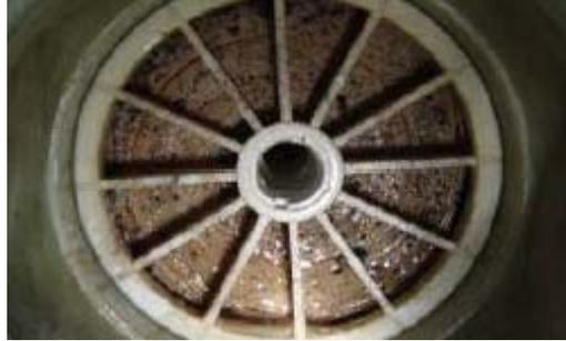
一般通過藥洗及消毒來解決微生物污染異常。詳情可參考：第三章《[膜系統清洗](#)》。因微生物繁殖性強，必須找到污染源進行針對性殺菌處理，否則短時間內，微生物會再次大量繁殖，造成系統重複性污堵。
